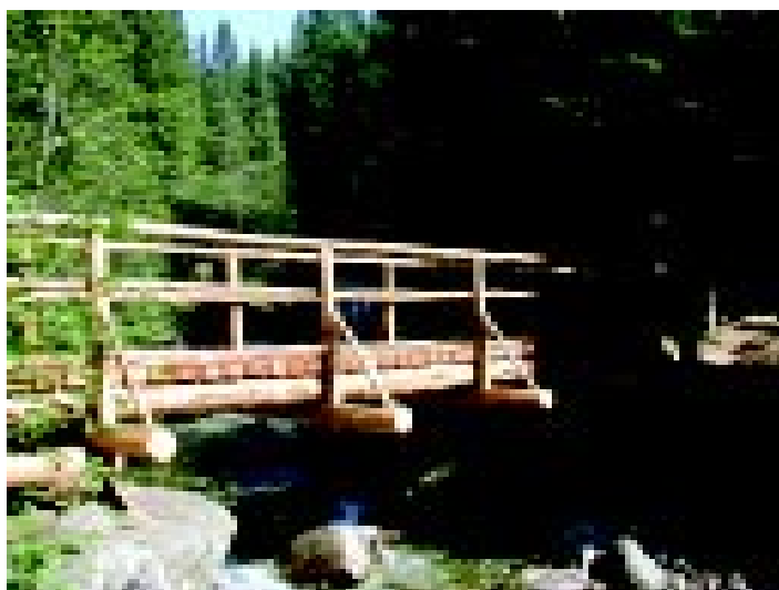
Sentiero E386: rifacimento passerella su torrente Grigno: prima e dopo la cura
